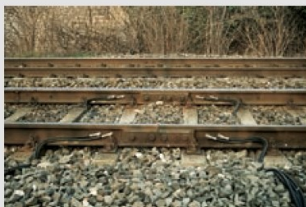
Propojení a ukolejnění kovových konstrukcí
